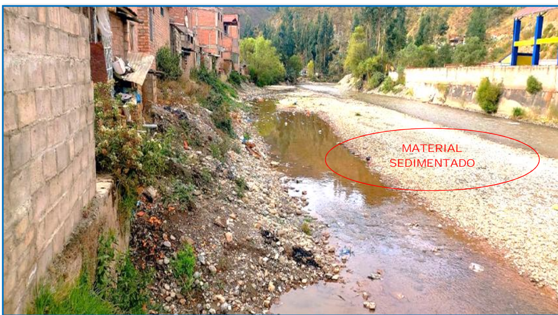
FIGURA N°02: MATERIAL SEDIMENTADO EN EL CAUCE DEL RIO HUALLAGA, CON UNA PROFUNDIDAD PROMEDIO DE 1.0 M. ESTO PROVOCA QUE DESBORDAMIENTO DEL RIO HUALLAGA SEA MAS INMINENTE.
